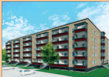
■ Viele Häuser werden nun neue Balkone erhalten.
