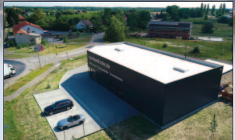
■ Die neue Ausstellungshalle ist verkehrsgünstig am Kreisverkehr von Glindow zu erreichen.
